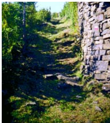
Tramo de sendero después de la limpieza de maleza
