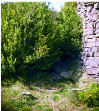
Tramo de sendero antes de realizar los trabajos de acondicionamiento
